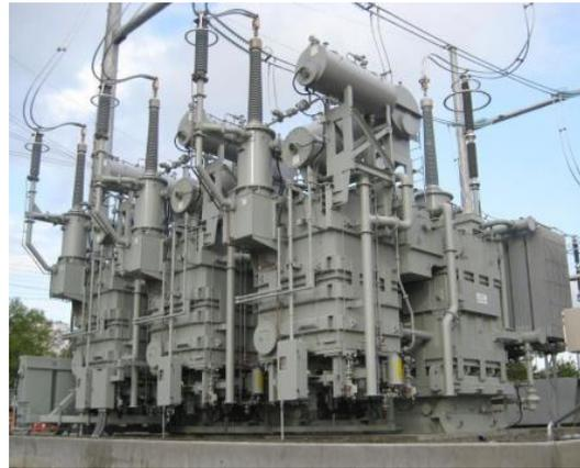
Speziell getrennter dreiphasiger Transformator
