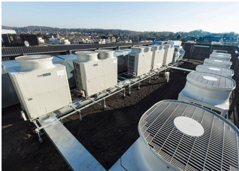
Energiesparende Klima- und Heiztechniklösungen aus der City Multi R2-Serie heizen und kühlen das Gebäude simultan.
